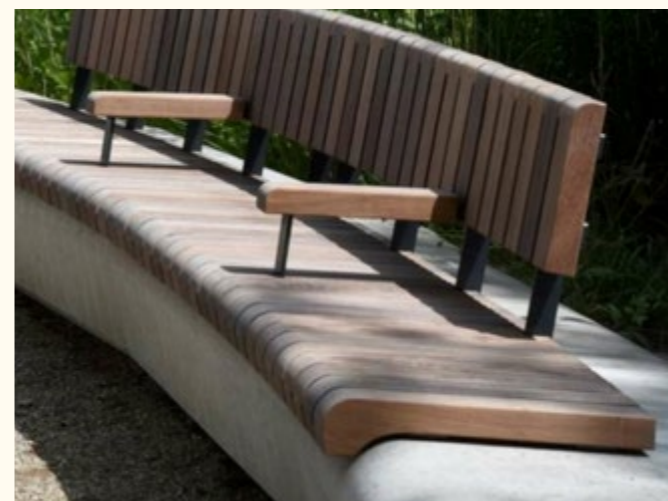
houten zittingen op betonrand
